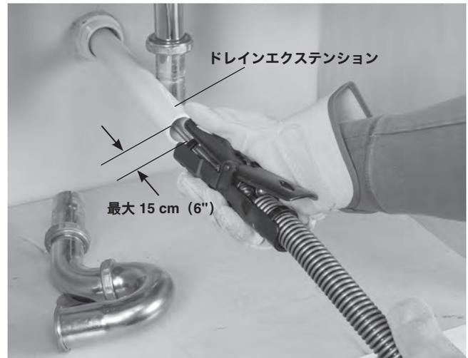
図 7 – AUTOFEED ユニットの 15 cm (6") 以内の範囲にする排水管延長の例
