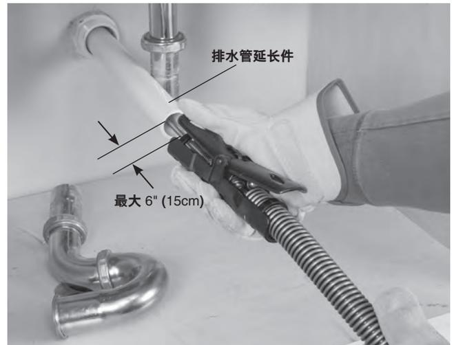
图 7 - 示例：将排水管延长至 AUTOFEED 单元 6" (15cm) 以内。
