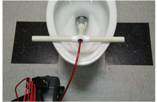
图22 ~ 使用 PVC 导管
