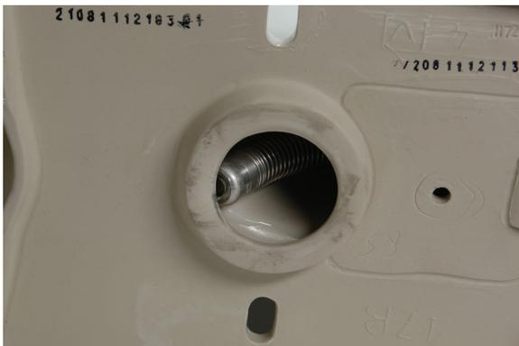
图16 ~ 摄像头在转弯处堵塞
