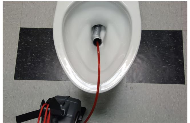
图23 ~ 使用柔韧的导管
