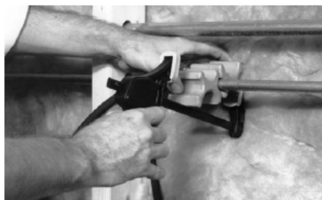
图3 — 用夹钳固定冷凝头
